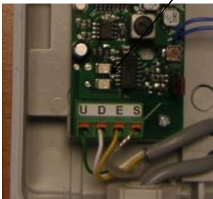
Bild 5: Teilausschnitt abgesetzte Antenne
