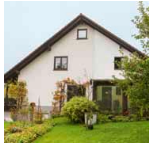
Deutlich zu erkennen: Das Haus von Rudolf Lehmler (oben) besteht aus zwei Hälften. Die Thermografie hat es gut bestanden.
