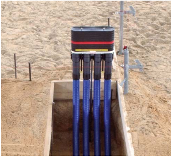
Beispiel für Anordnung des Rohbauteils vor dem Betonieren der Bodenplatte – Quelle FHRK
