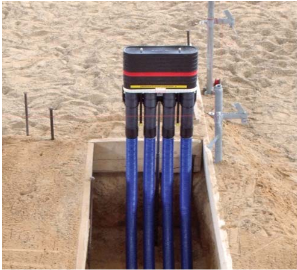
Beispiel für Anordnung des Rohbauteils vor dem Betonieren der Bodenplatte – Quelle FHRK
